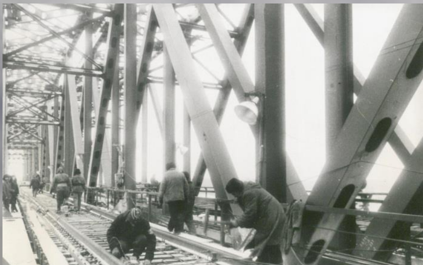
Отделка пути на русловом мосту через Дон. ЦДНИРО. Ф.Р-3619. Текущий архив
