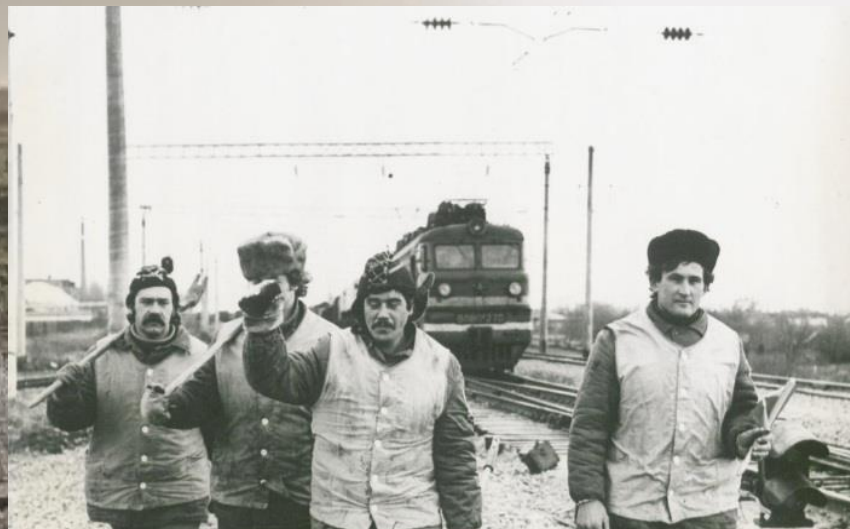
Передовая бригада путейцев строительно-монтажного поезда -550. ЦДНИРО. Ф.Р-3619. Текущий архив
