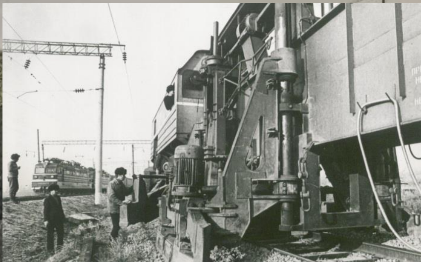
Подбивка участка пути машинами. ЦДНИРО. Ф.Р-3619. Текущий архив
